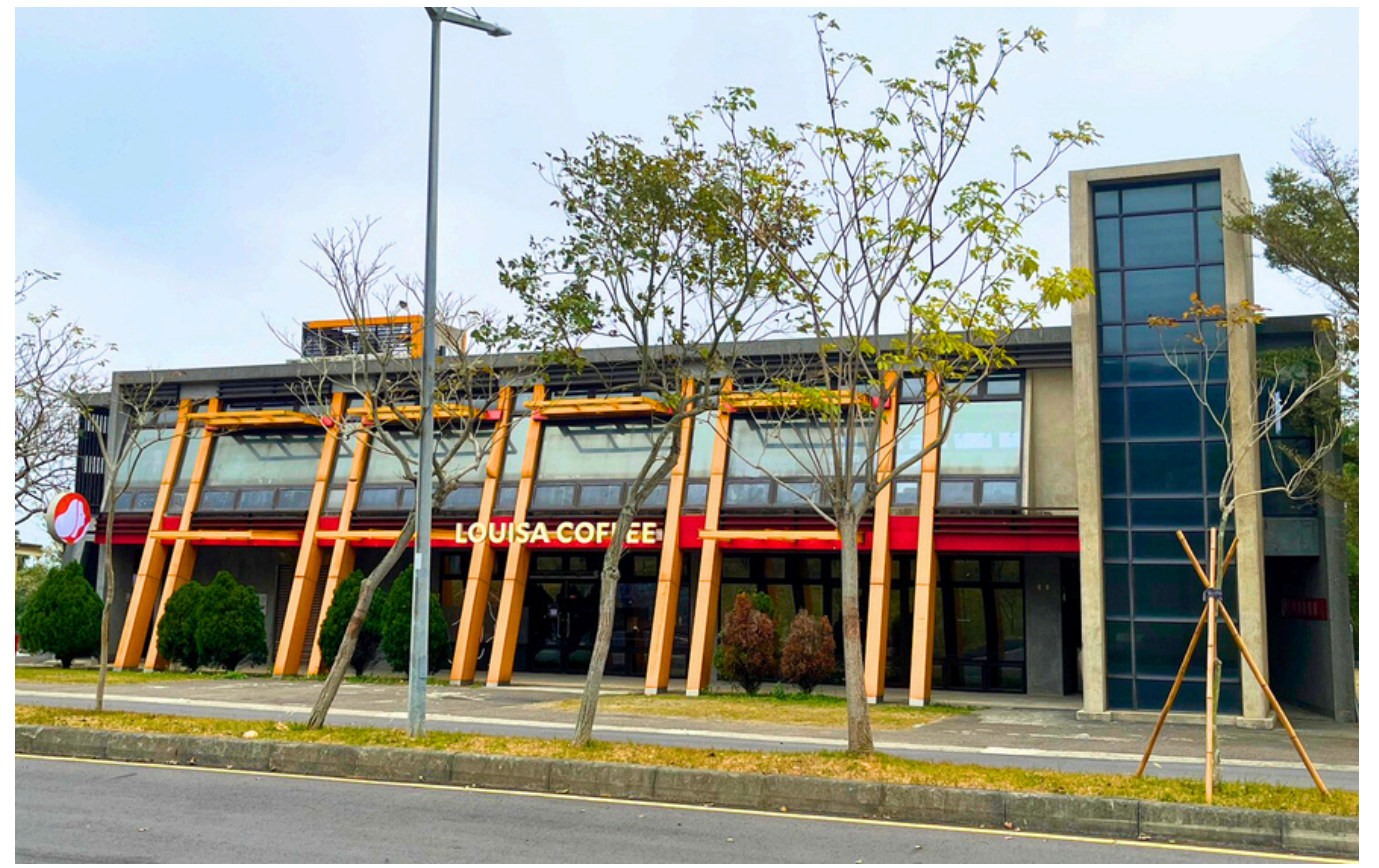
整棟建物校內側拍攝圖
