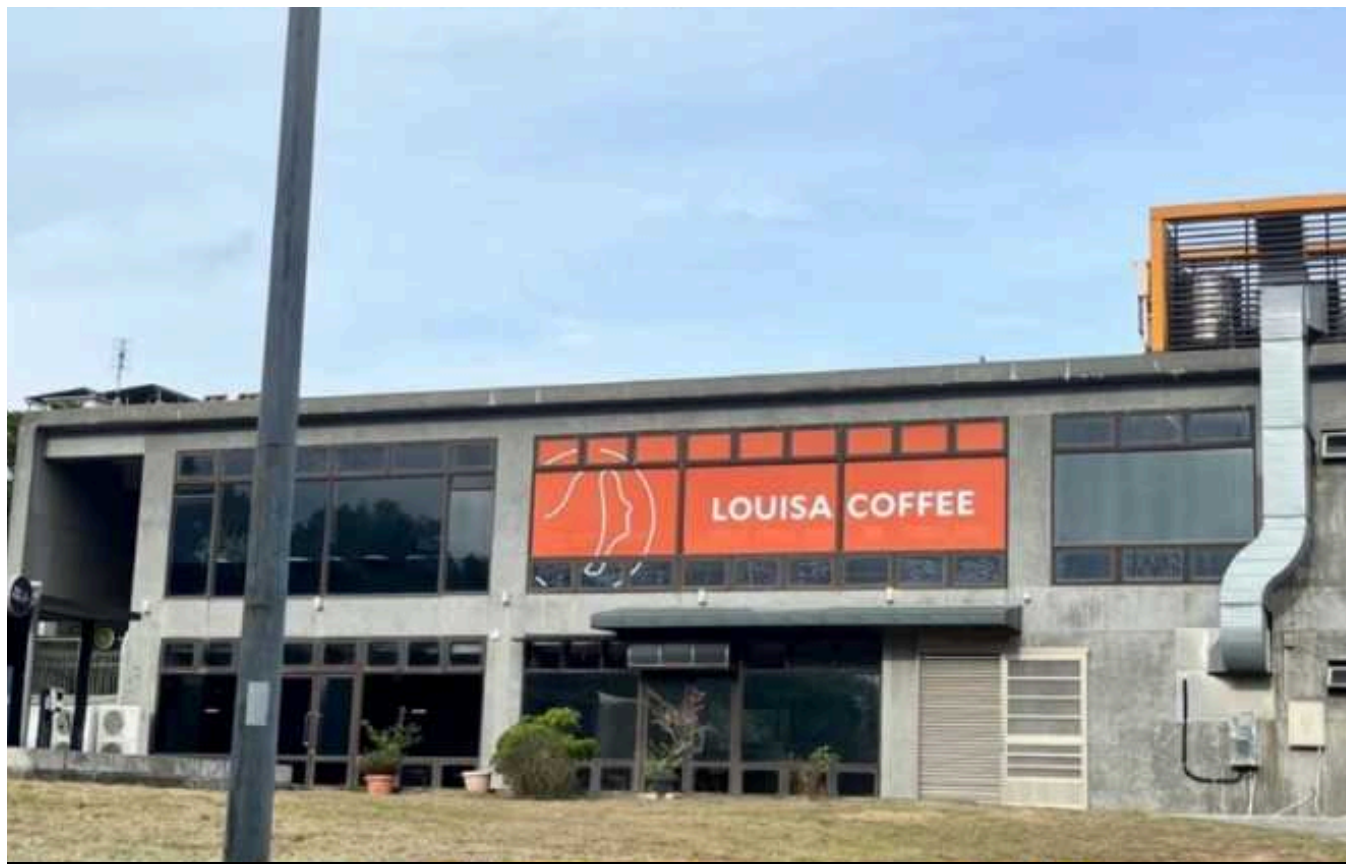
整棟建物校外側拍攝圖
