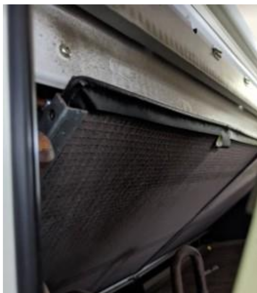
圖三 箱型空調機濾網積塵
