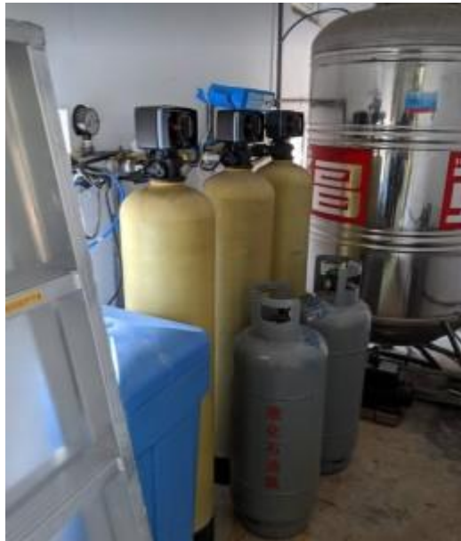
圖二 中央純水過濾系統
