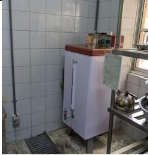
圖一 30加侖之儲熱型電開水機
